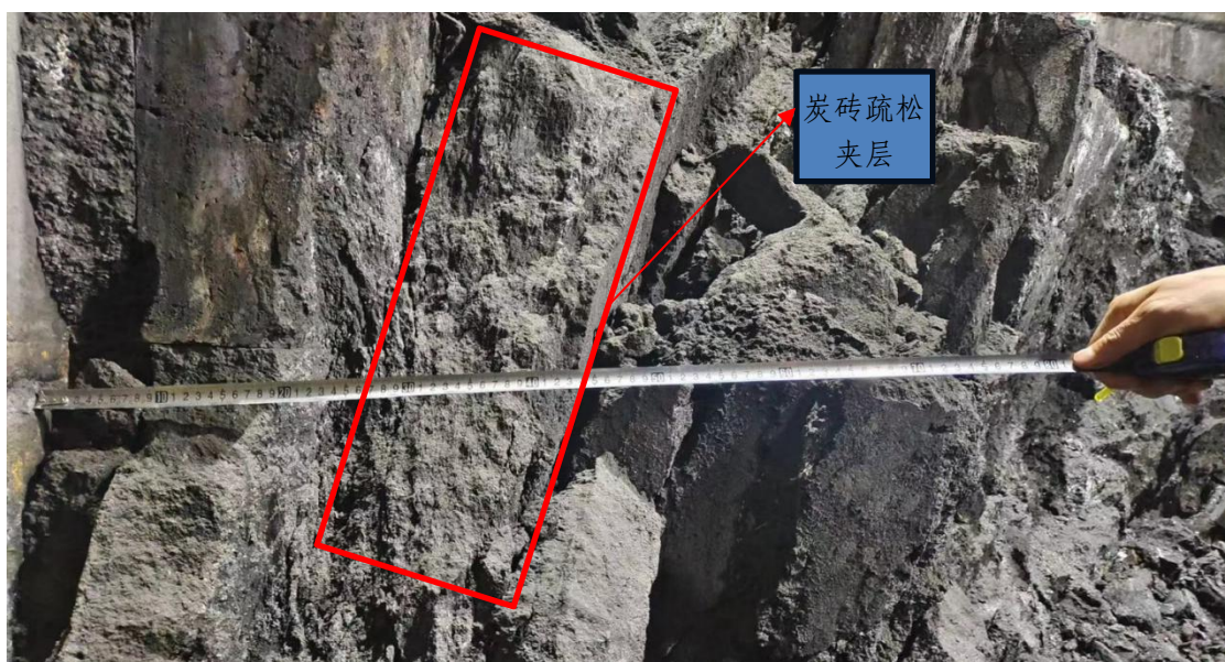
图 6 事故高炉炉缸南侧环向疏松夹层
